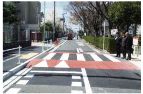
ハンプ（道路の一部を山のように盛り上げて車の速度を抑制するもの）が設置された横断歩道。自動車速度の低減をはかり、歩道と車道の段差が小さくなりスムーズに横断できる
