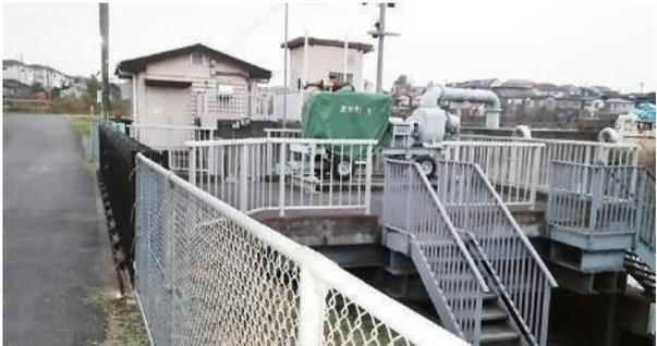
埼玉県志木市の排水機場。1分間に282m<sup>3</sup>排水できるポンプが設置されている。粕江市のポンプ（今後増設されるポンプも含め六郷排水樋管5m<sup>3</sup>/分、猪方排水樋管2m<sup>3</sup>/分）の5.6倍～14.1倍の排水能力がある。
