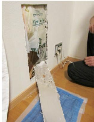
床上浸水で壁の中の断熱材が水を吸って壁の裏にカビが生えた（駒井町、11月14日撮影）
